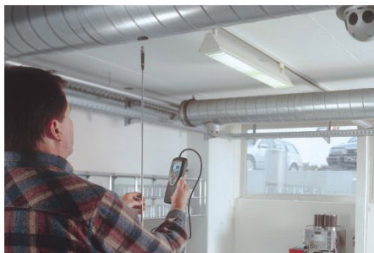
testo 416, 检测厨房内的供风量
